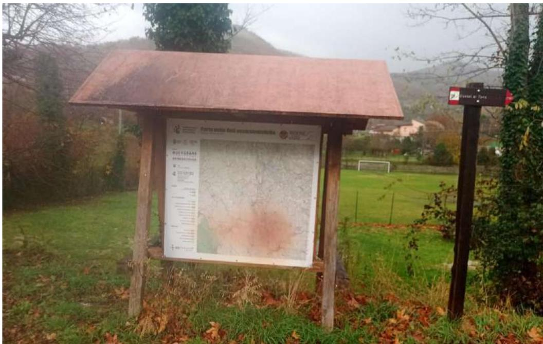
Foto 2 - Pannello cartografico cm. 120 x 120 deteriorato
