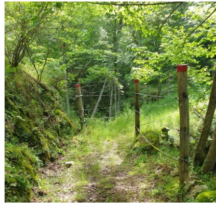
Intervento 4: protezione a valle imbocco ponte e pulizia del ponte stesso
