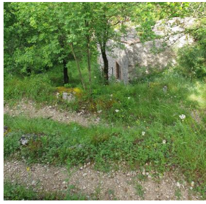
Intervento I2 e I3: protezione prima e dopo accesso Mola per complessivi 25 metri - Pali in legno e corde
