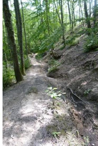
**Fig. 8** – Pista forestale presso Cesaiese nel punto in cui sbocca nella strada dell’Obito, caratterizzata da profondi solchi ed erosione.
